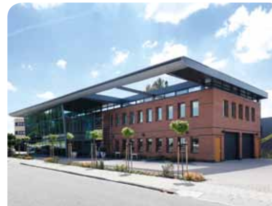
Het voormalige autobedrijf met showroom en werkplaats werd omgebouwd tot luxe kantoorpand.
