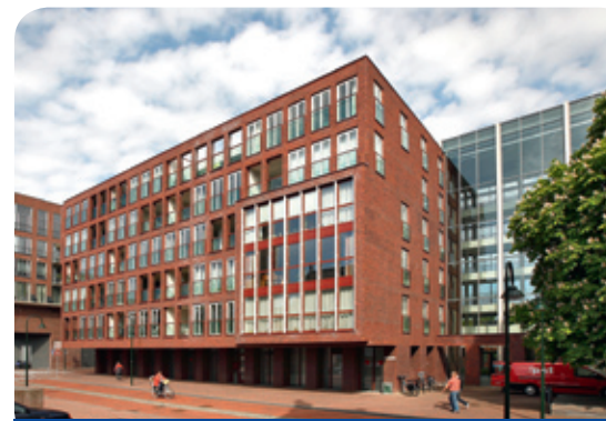
MD Service deed multidisciplinair installatiewerk in de dokterspost, back office en apotheek.
