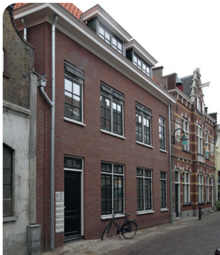
MD Service deed de volledige elektrotechnische installatie van dit complex aan de Keizerstraat.
